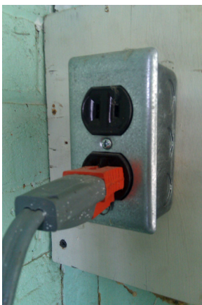
Figura 3. Algunos enchufes requieren el uso de un adaptador de 3-patas para usar el monitor de energía.
